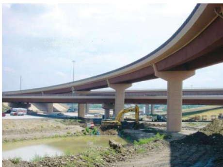
(ข) รูปแบบทางเลือกที่ 2 โครงสร้างคานคอนกรีตอัดแรงรูปตัว U หล่อสำเร็จ (Precast Concrete U- Girder)
