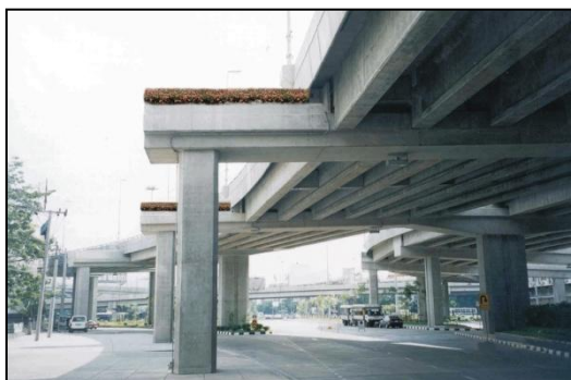
(ก) รูปแบบทางเลือกที่ 1 โครงสร้างคานคอนกรีตอัดแรงรูปตัว I หล่อสำเร็จ (Precast I-Girder)
