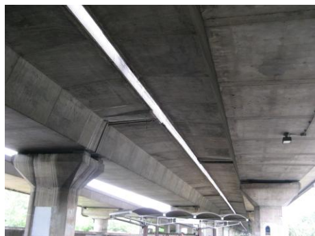
(ค) รูปแบบทางเลือกที่ 3 โครงสร้างคานคอนกรีตอัดแรงรูปกล่องหล่อสำเร็จ (Precast Segmental Box Girder)
