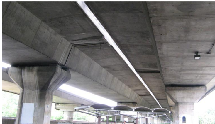
รูปที่ 2.3-5 โครงสร้างคอนกรีตอัดแรงรูปกล่องหล่อสำเร็จ
